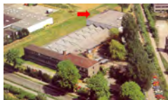
mit einem modernen Hochregallager in Tönisvorst with a modern high-rack storage
