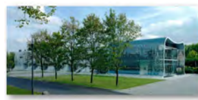
Einweihung des neu gebauten Fertigungs- und Innovationszentrums (FIZ) Inauguration of the new Production- and Innovation Center (PIC) at the company site in Tönisvorst
