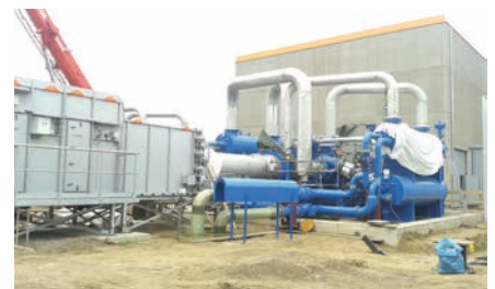
Die Baustelle im August 2014 The construction site in August
