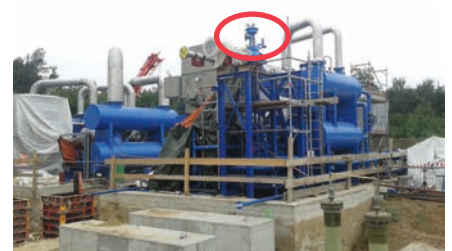
Montage der Verdichter vor Ort, oben ein Bypass-Regelventil DN200 Installation of the compressors on site; at the top, a DN200 bypass control valve
