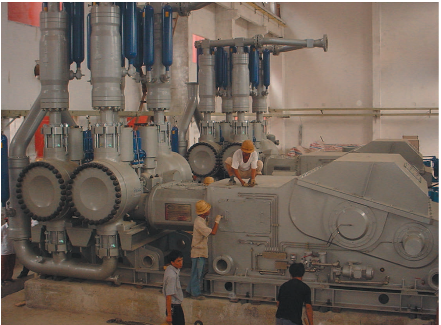
Montage der FELUWA Schlauch-Membran-Kolbenpumpen in der Provinz Chongqing / V.R. China Installation of FELUWA Hose Diaphragm Piston Pumps in Province of Chongqing / P.R. China
